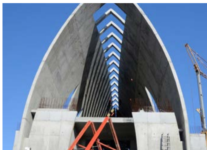
Widok rozszalowanej ściany szczytowej – etap pierwszy wraz ze stropem empory
