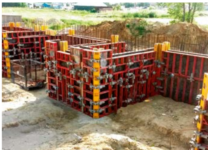
Etap szalowania ław fundamentowych nawy głównej kościoła
