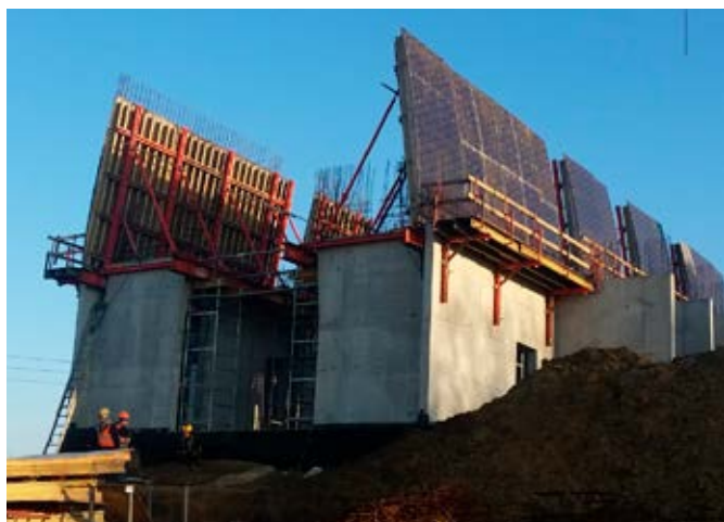
Etap wznoszenia szalowania pierwszej części łukowej ścian nawy głównej
