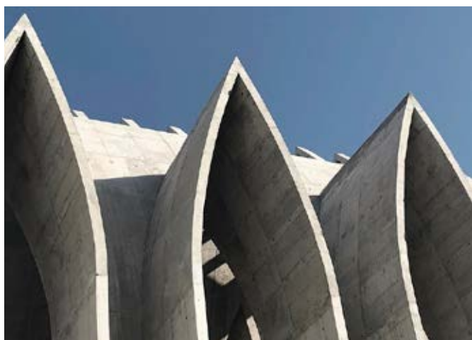
Widok kapliczek bocznych po rozszalowaniu ostatniego etapu betonowania
