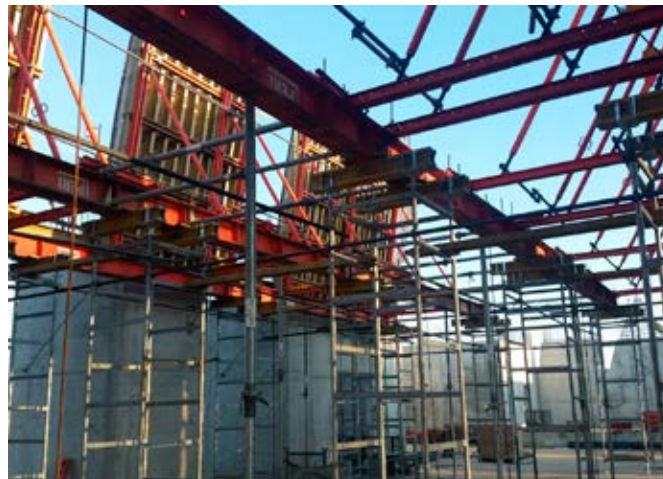
Podbudowa z wież ST-100 z oczepem z dźwigarów stalowych HEB 400
