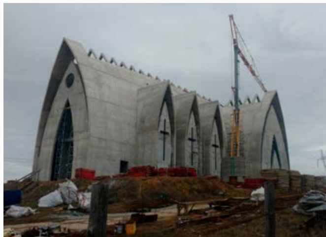
Stan zaawansowania budowy na dzień dzisiejszy
