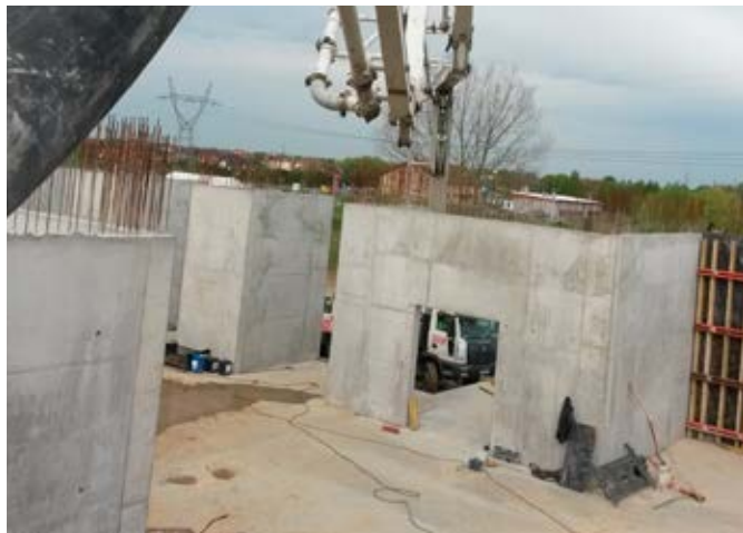
Odcinki proste ścian kościoła
