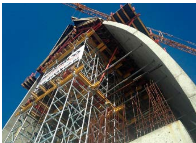
Etap szalowania zwornika łuku
