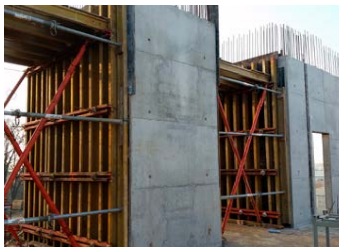
Zakończony pierwszy etap betonowania ścian kościoła – odcinek prosty
