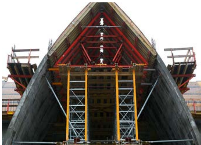
Widok szalunku przed betonowaniem zwornika łuku nawy głównej
