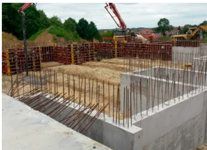
Widok ław fundamentowych w kaplicy głównej po rozszalowaniu
